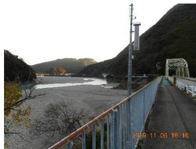
16:16 熊野川と八木尾橋
