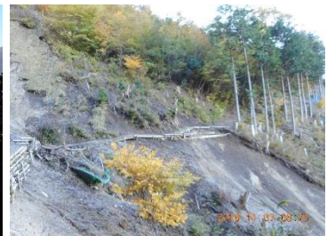
8:23 崩落個所を修復
