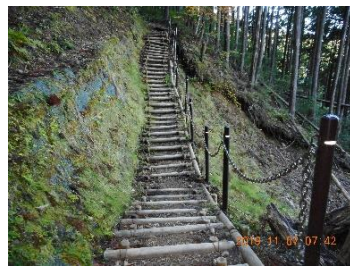
7:42 崩落後に整備された丸太階段
