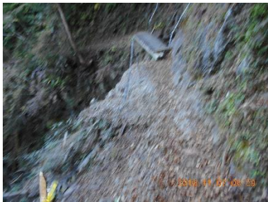
8:29 崩落個所にハシゴが架かっている
