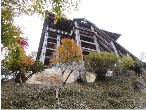
14:05 巨岩の上に建つ観音堂の上部
