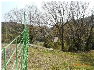
14:35 猪侵入防止柵、中央は遍路道表示板
