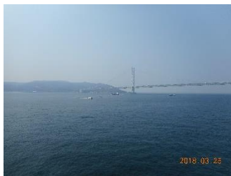
12:08 明石海峡大橋と淡路島
