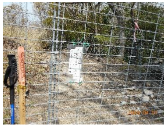
13:06 猪侵入防止柵
